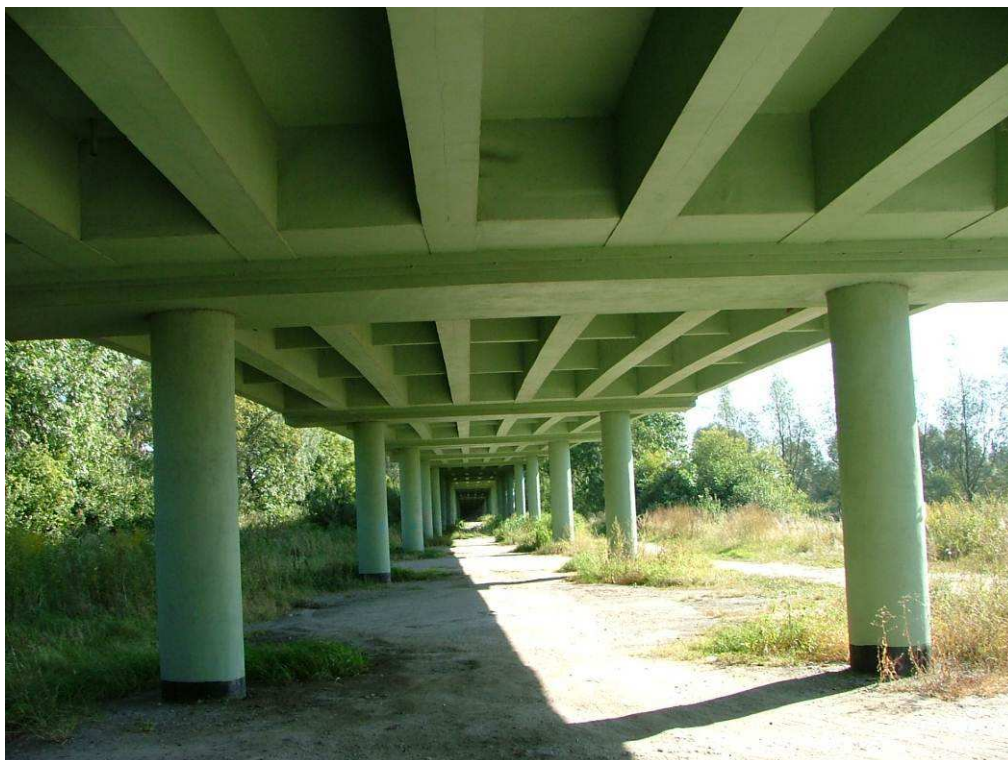
Fot. 6 Widok na konstrukcję oraz filary wiaduktu
