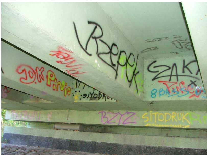
Fot. 37 Przyczółek i dźwigary w strefie przyczółkowej
