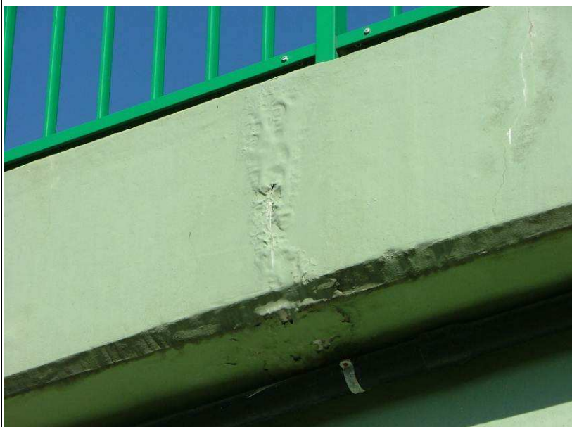
Fot. 13, 14, 15 Betonowe gzymsy
