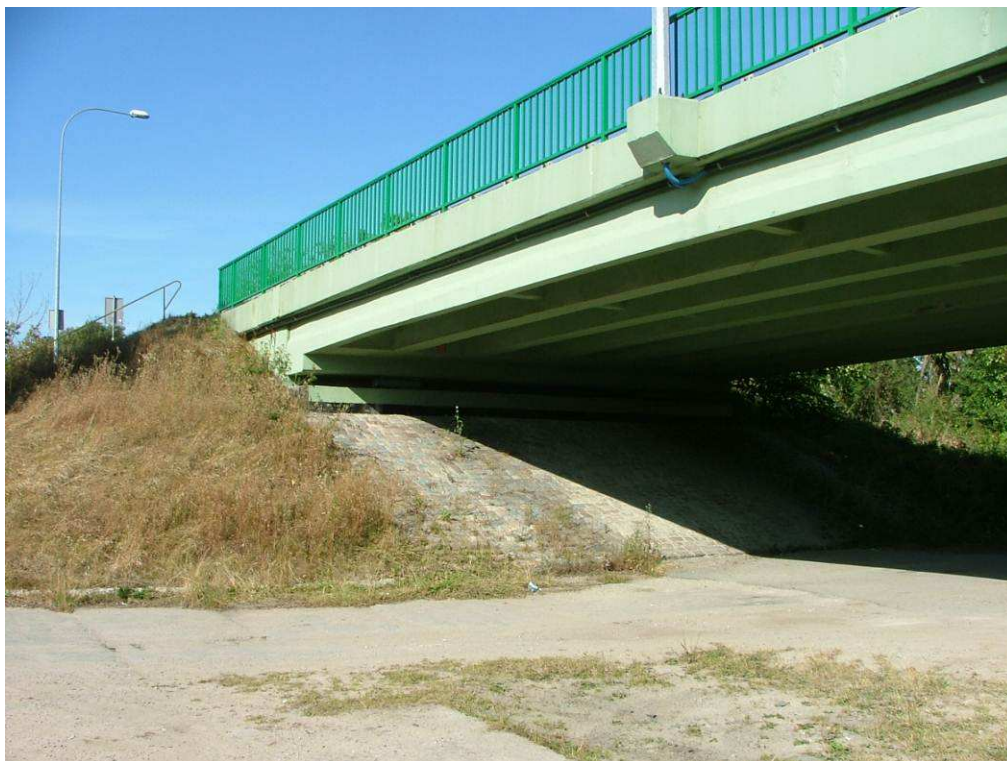
Fot. 9 Widok na przyczółek od Gdańska
