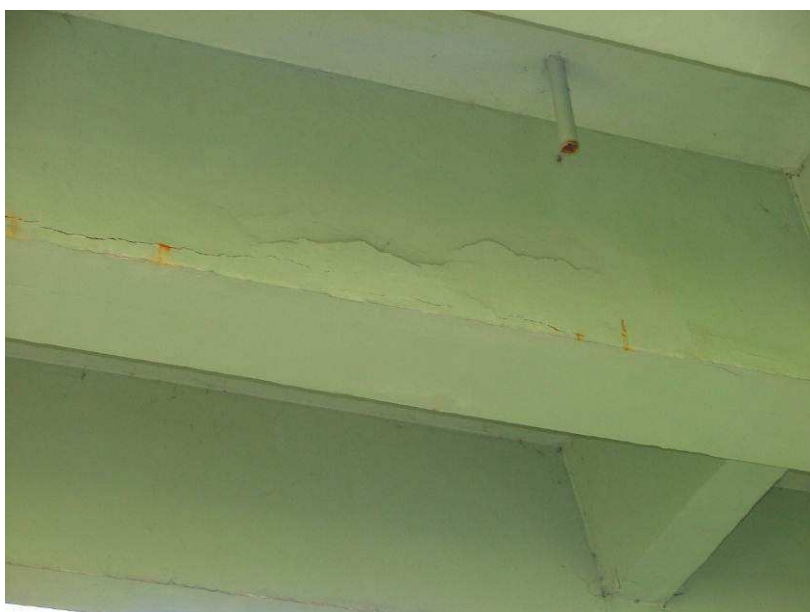
Fot. 16, 17, 18 Dźwigary główne
