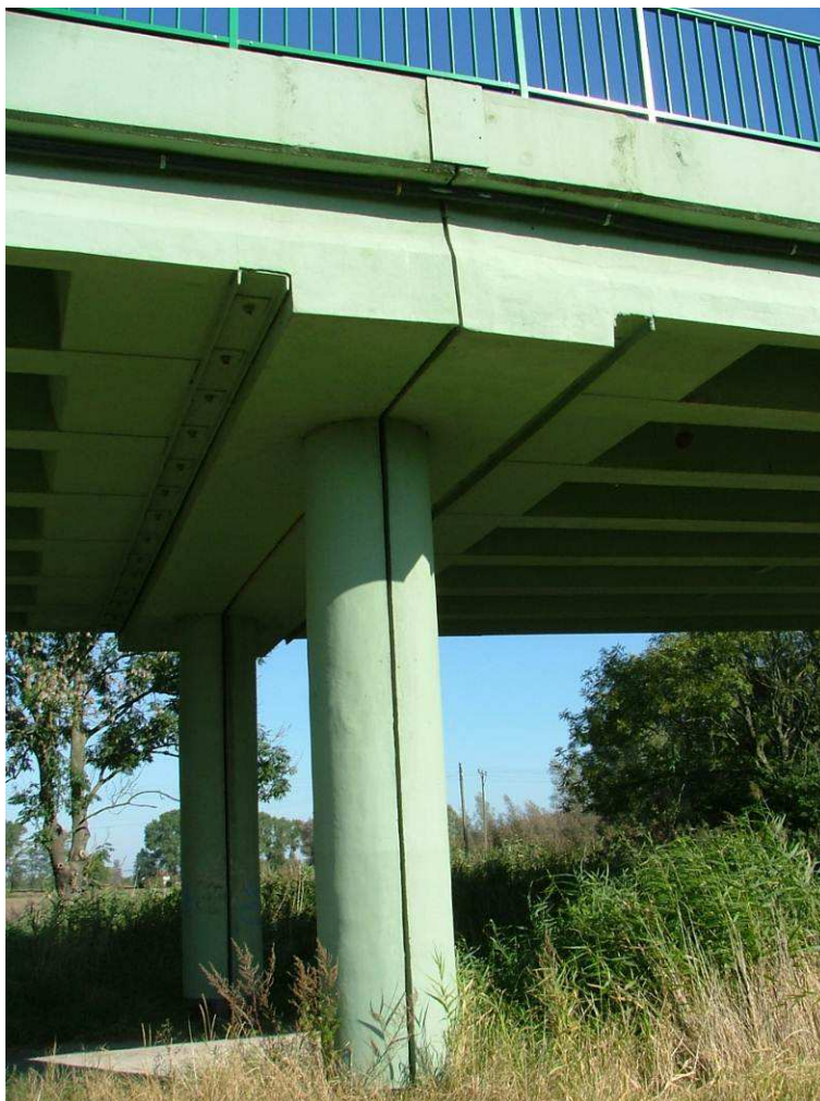
Fot. 7 Widok na dylatację obiektu
