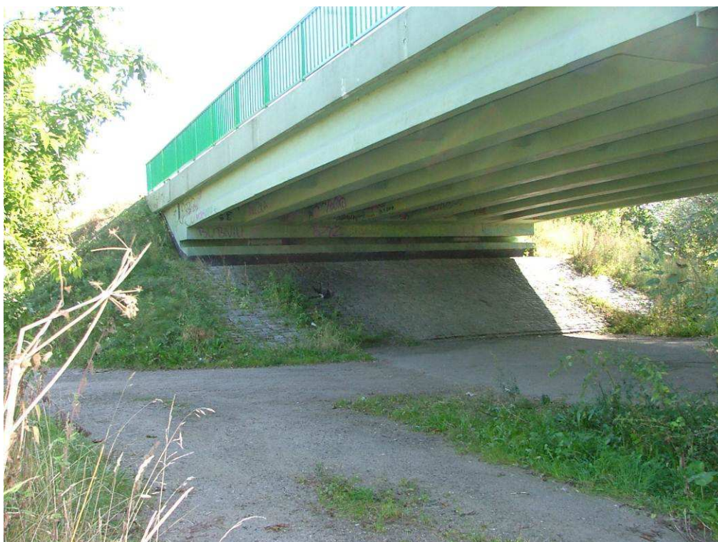
Fot. 10 Widok na przyczółek od strony Elbląga
