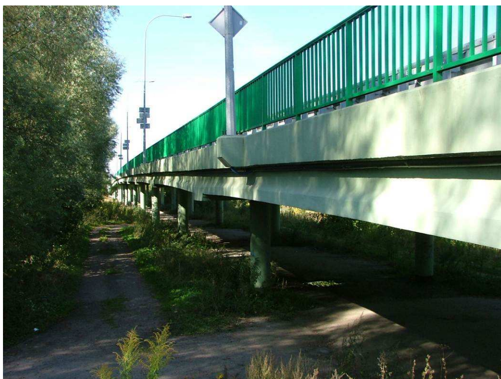
Fot. 2 Widok południowy od strony Elbląga
