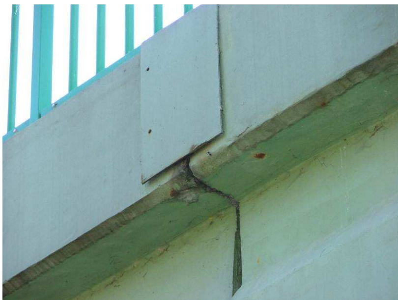
Fot. 31, 32 Blachy osłonowe dylatacji
