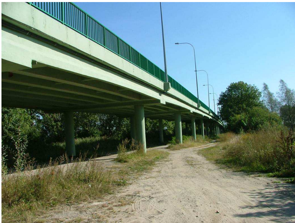
Fot. 5 Widok południowy od strony Gdańska
