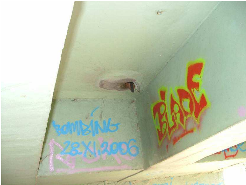
Fot. 40 Rura spustowa odwodnienia
