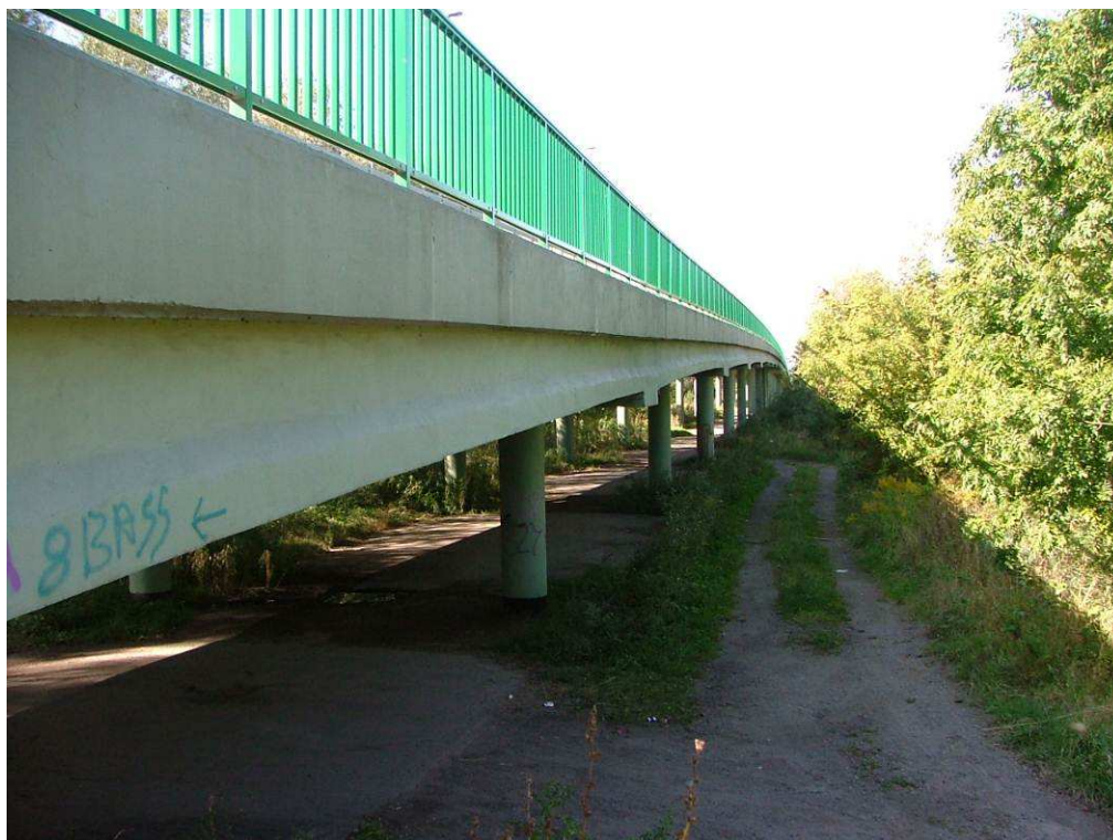
Fot. 1 Widok północny od strony Elbląga
