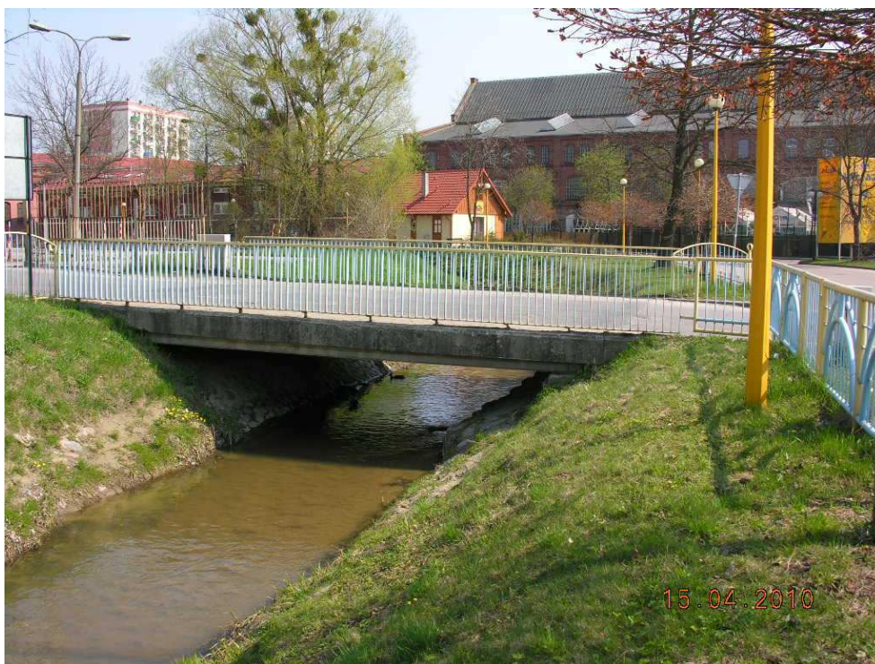
Fot. Nr 6. Przepust nad Kumielą – południowa część ul. Związku Jaszczurczego.
