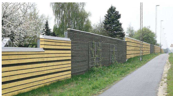
Rys. 10.16. Ekran przeciwhałasowy (cegła, drewno)
