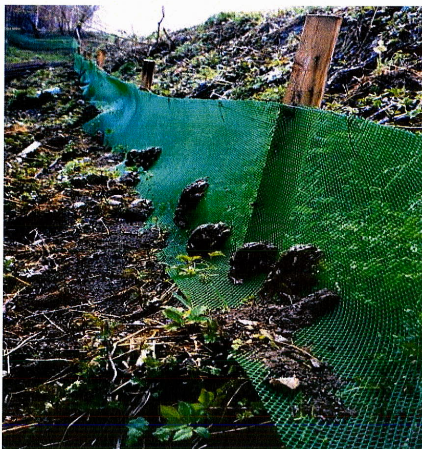
Rys. 9. Zabezpieczenia używane na etapie budowy.
